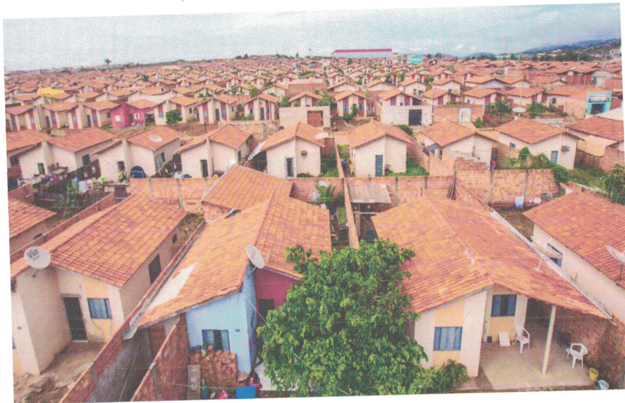
Figura 4. Residencial dos Minérios.
