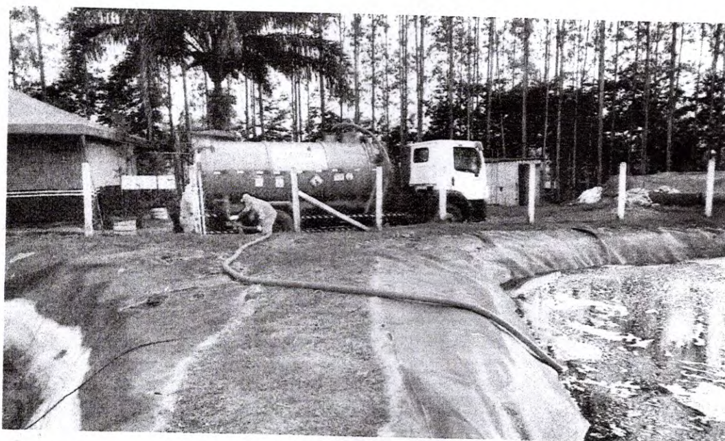
10 – Recirculação de chorume utilizando Limpa Fossa
