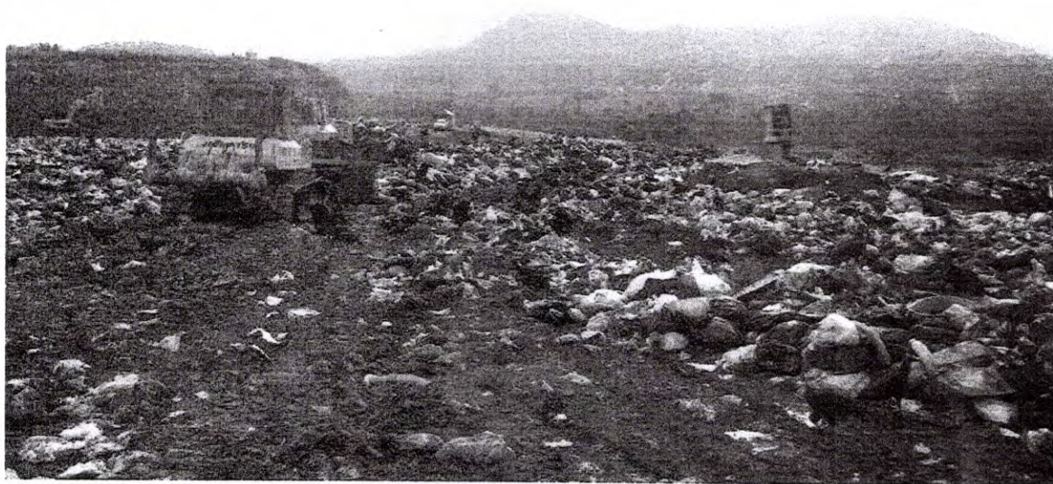
04 – Espalhamento e compactação dos resíduos – Manutenção
