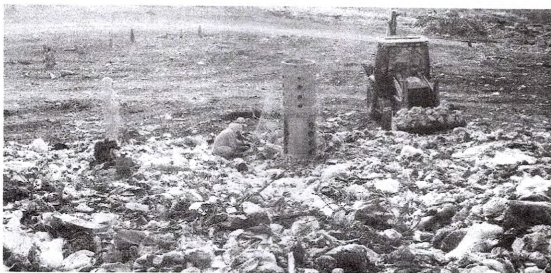
06– Manutenção no sistema de drenagem de gases
