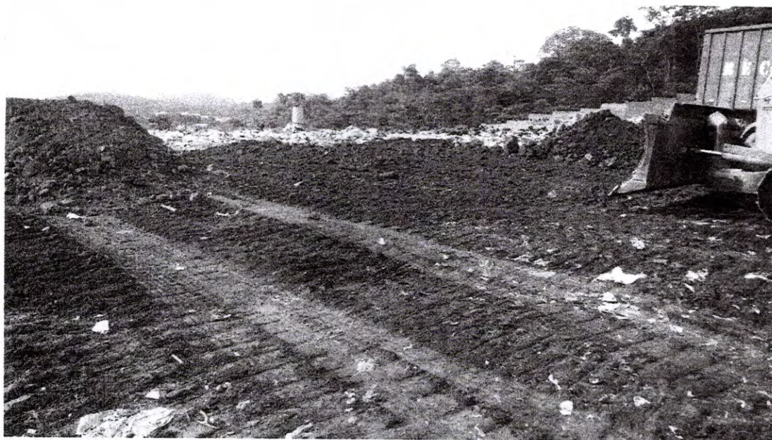
07 – Cobertura dos resíduos compactados – Manutenção
