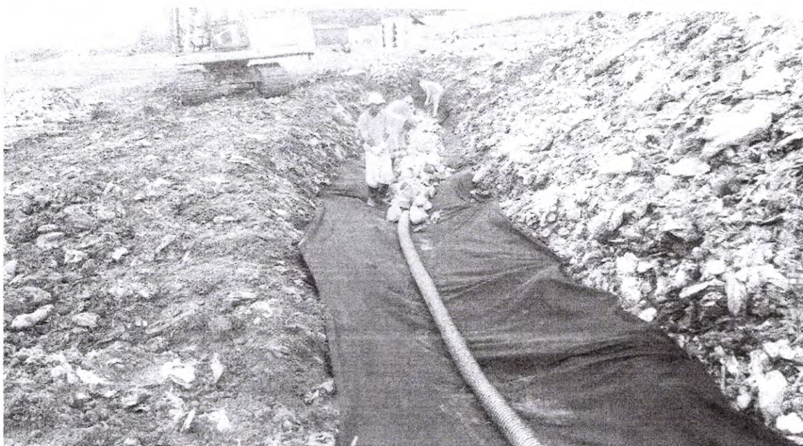
02 - Execução de sistema de Drenagem - Operação
