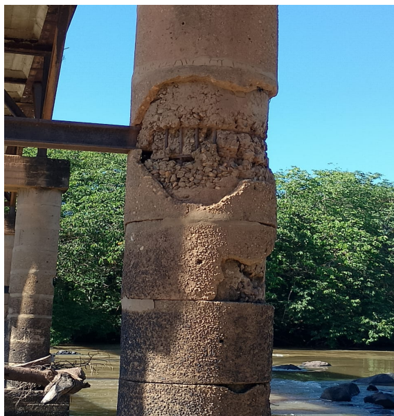
Foto 2º Pilar direito da ponte na vicinal do limão.
